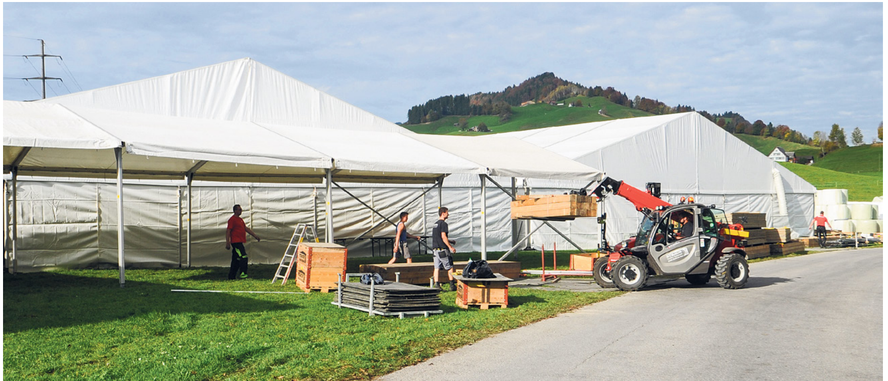
Noch drei Wochen trennen Aussteller und Gäste von der Gewerbemesse «A17». Zurzeit laufen die Vorbereitungen an allen Fronten. Die Zelte sind aufgebaut.
